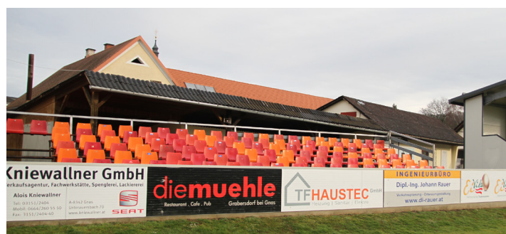
Die neu errichtete Stadion-Nordtribüne.
