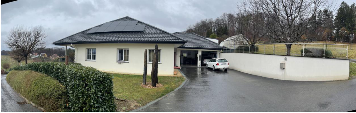
Abbildung 6: Baulicher Bestand Bauplatz 2
